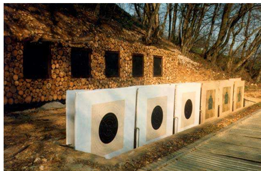
Kugelfang einer 300m Schiessanlage
